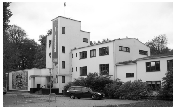
HOVEDBYGNINGEN MED INDGANG TIL STUEPLAN.
